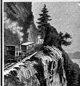
Kräbelwand Partie der Arth-Rigi-Bahn
