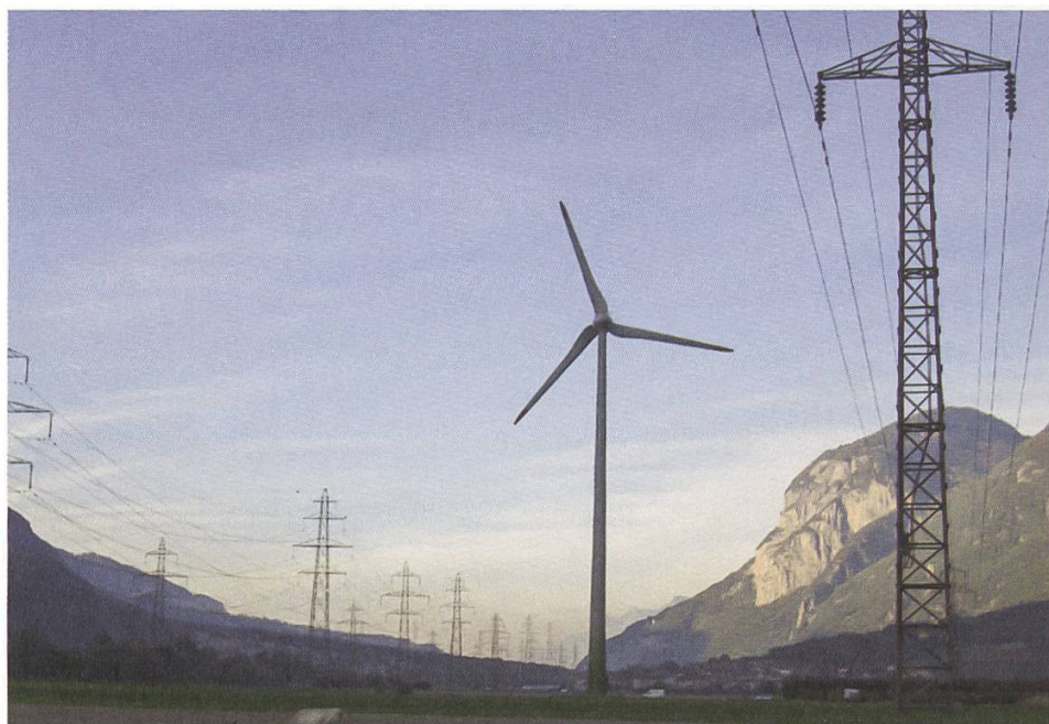
Windkraftanlage in Collonges VS nahe der Stromleitung
