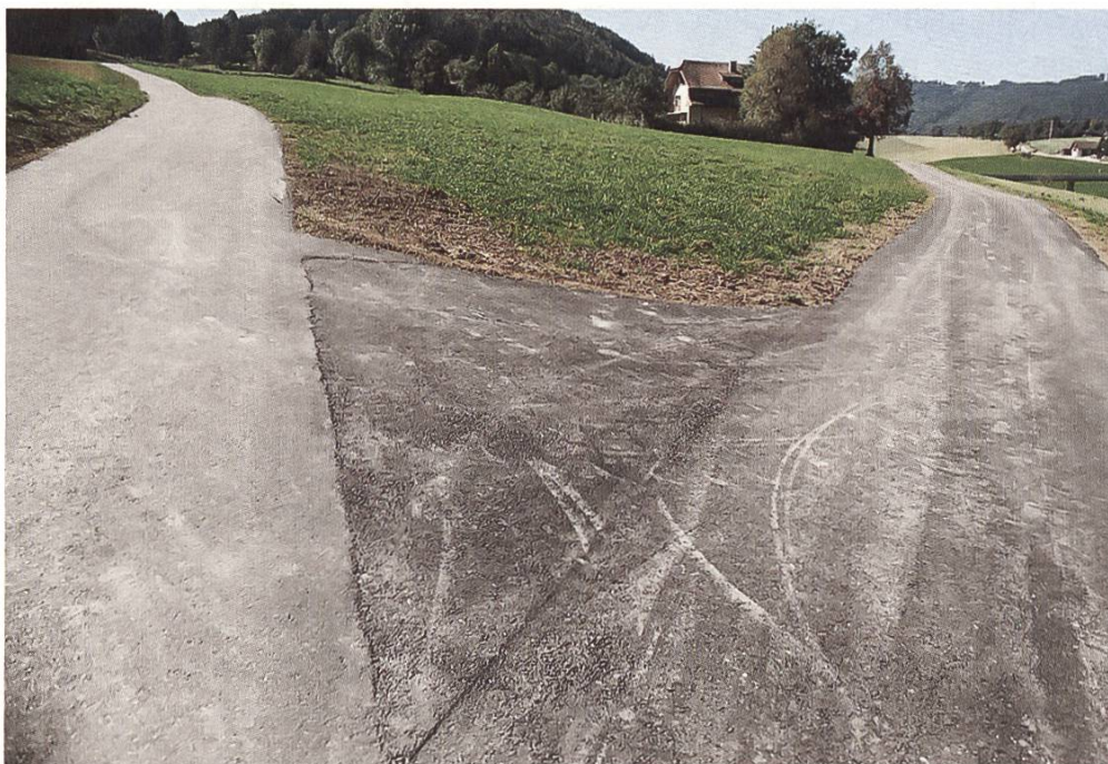
Neu asphaltierter Flur- und Wander- weg bei Tavannes BE
