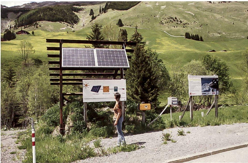
Modell der Solaranlagen an der Lawinenverbauung St. Antönien
