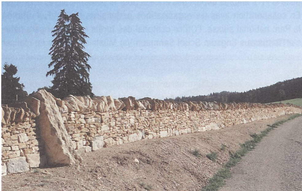
Die wiederhergestellte Trockenmauer von Muriaux BE
