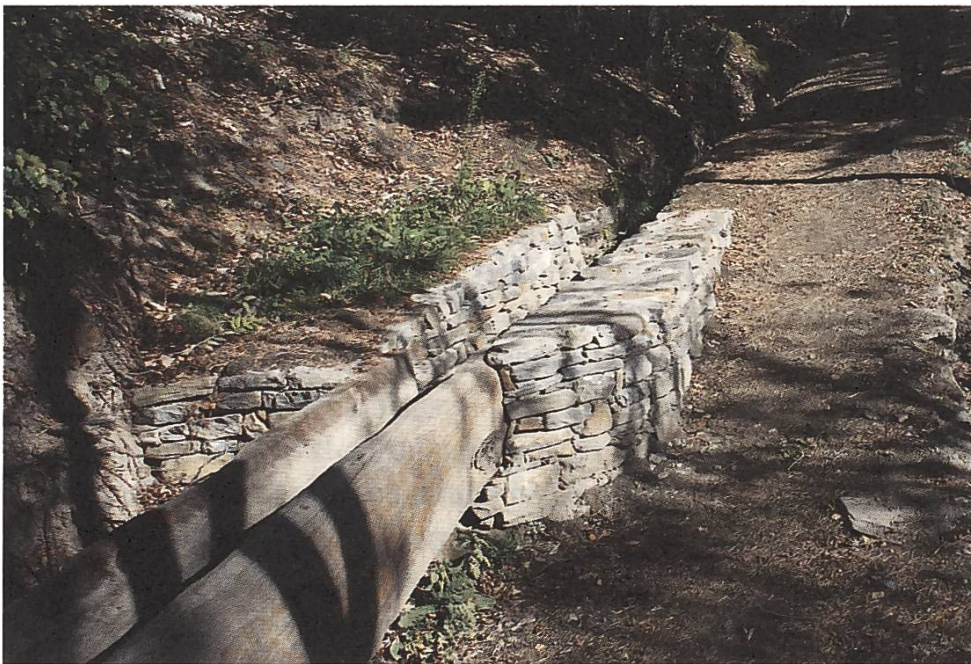
Die sanierte Suone Manera in Ausserberg VS
