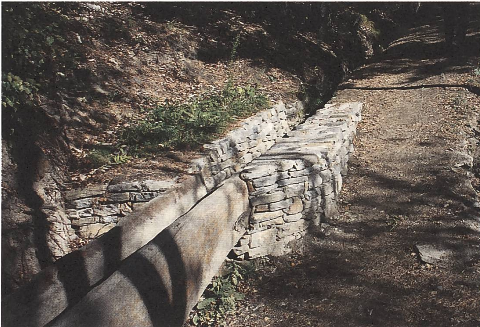
Die sanierte Suone Manera in Ausserberg VS
