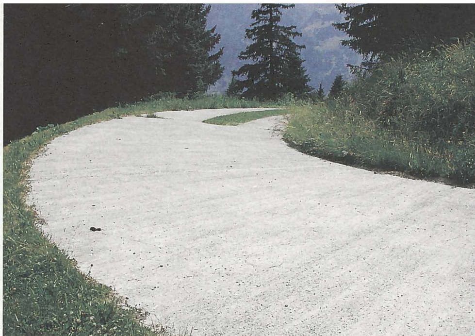
Chemin bétonné à Pagig/Schanfigg GR
