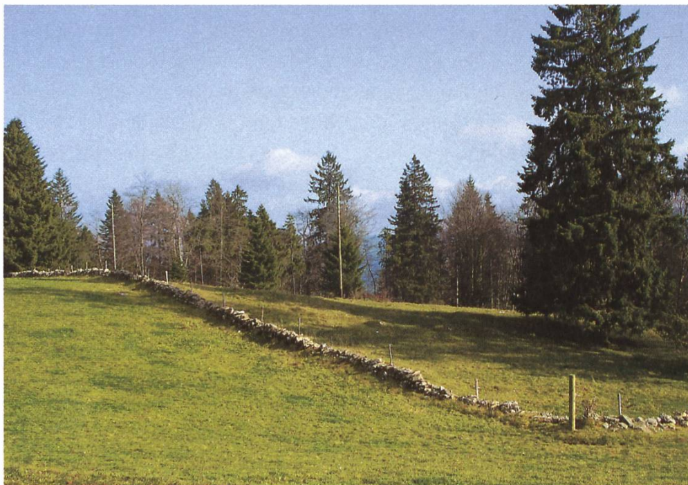
Restauration einer Trockenmauer in Villeret BE
