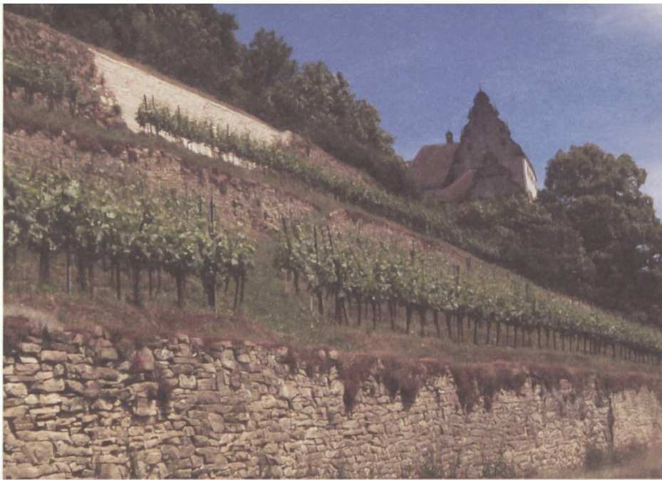
Sanierte Trocken- mauer beim Schloss Chastelen im Schenkenbergertal AG
