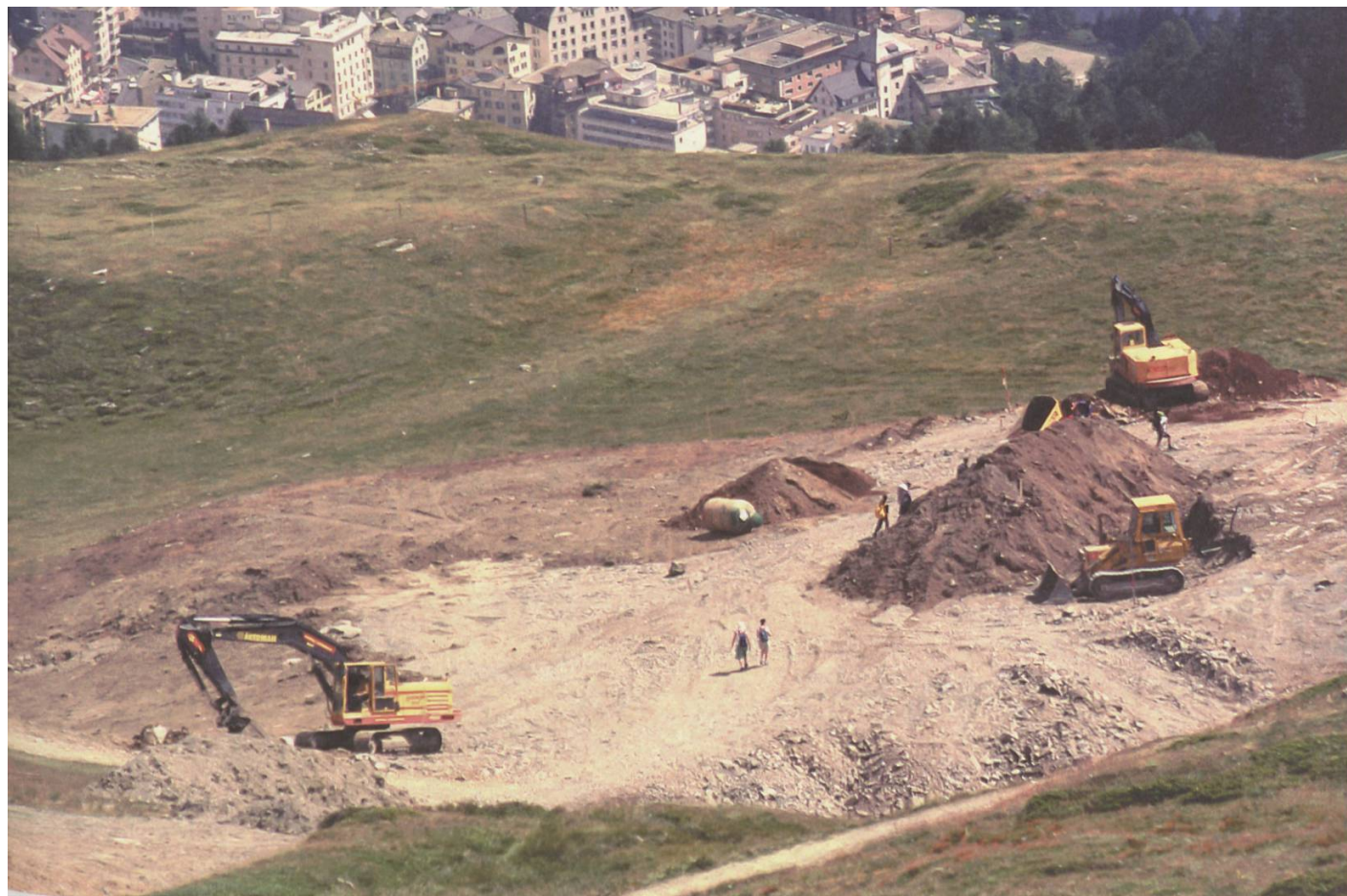
Bauarbeiten beim «Grossen Loch» für die WM 2003 in St. Moritz GR
