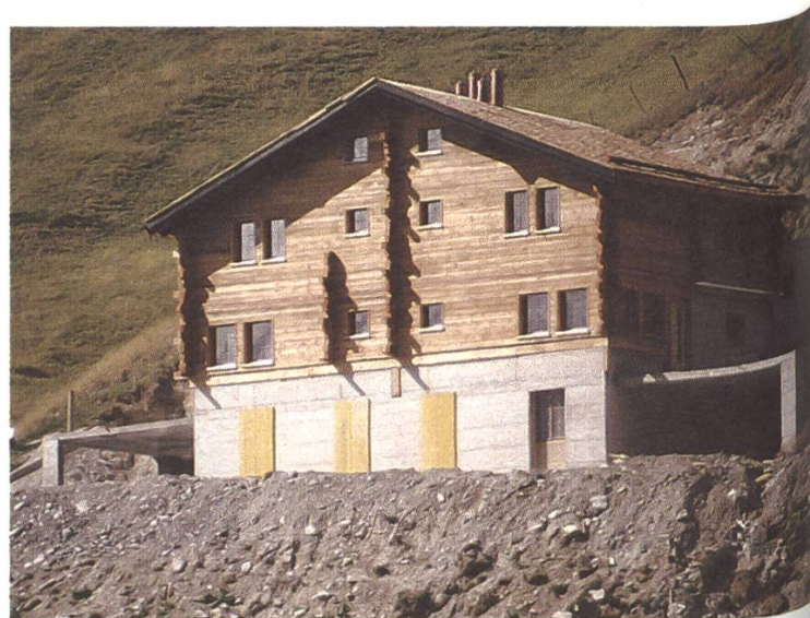
Einer der hängigen Fälle illegalen Bauens im Wallis (Albinen)
