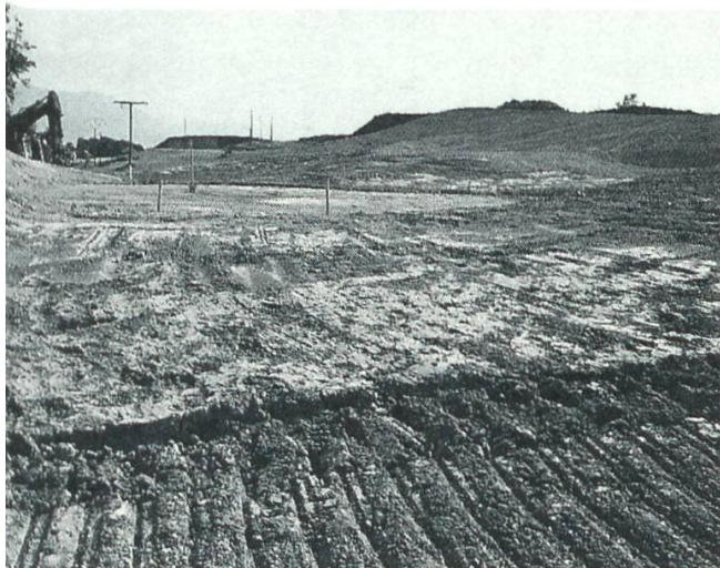
Der Golfkritiker erwiderst: Es wird das Gelände grossflächig mit schweren Baumaschinen ummodelliert, die «Tees» und «Greens» werden planiert und Drainagerohre verlegt, eine ökologisch wertlose Rasendecke wird eingesät. Grosse, bis-
