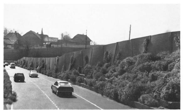
Müssen Lärmschutzwände hässlich sein? Die Modellaufnahme zeigt eine nach Auffassung der SL gelungene, aus Stahlnetzen mit Spritzbeton aufgebaute Konstruktion des «Atelier 5», Bern. Die wechselnde Neigung der Stützen garantiert nicht nur Stabilität sondern auch wechselvolles Spiel von Licht und Schatten sowie verschiedene «ökologische Nischen».
