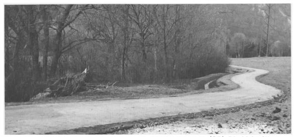
Gutes Beispiel einer Meliorationsstrasse bei Rothenbrunnen (GR). Die Linienführung wurde dem bestehenden Bachgehölz angepasst, das auf diese Weise erhalten bleibt. Bon exemple d'une route d'amélioration foncière à Rothenbrunnen (GR). Le tracé suit la sinuosité de la rive boisée qui peut ainsi être maintenue.
