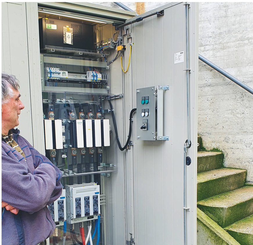
Otto Wartmann neben der Installation, mit der auf dem Holzhof die Notstromversorgung mittels erneuerbaren Energien untersucht wurde. Bilder: Fleco Power
