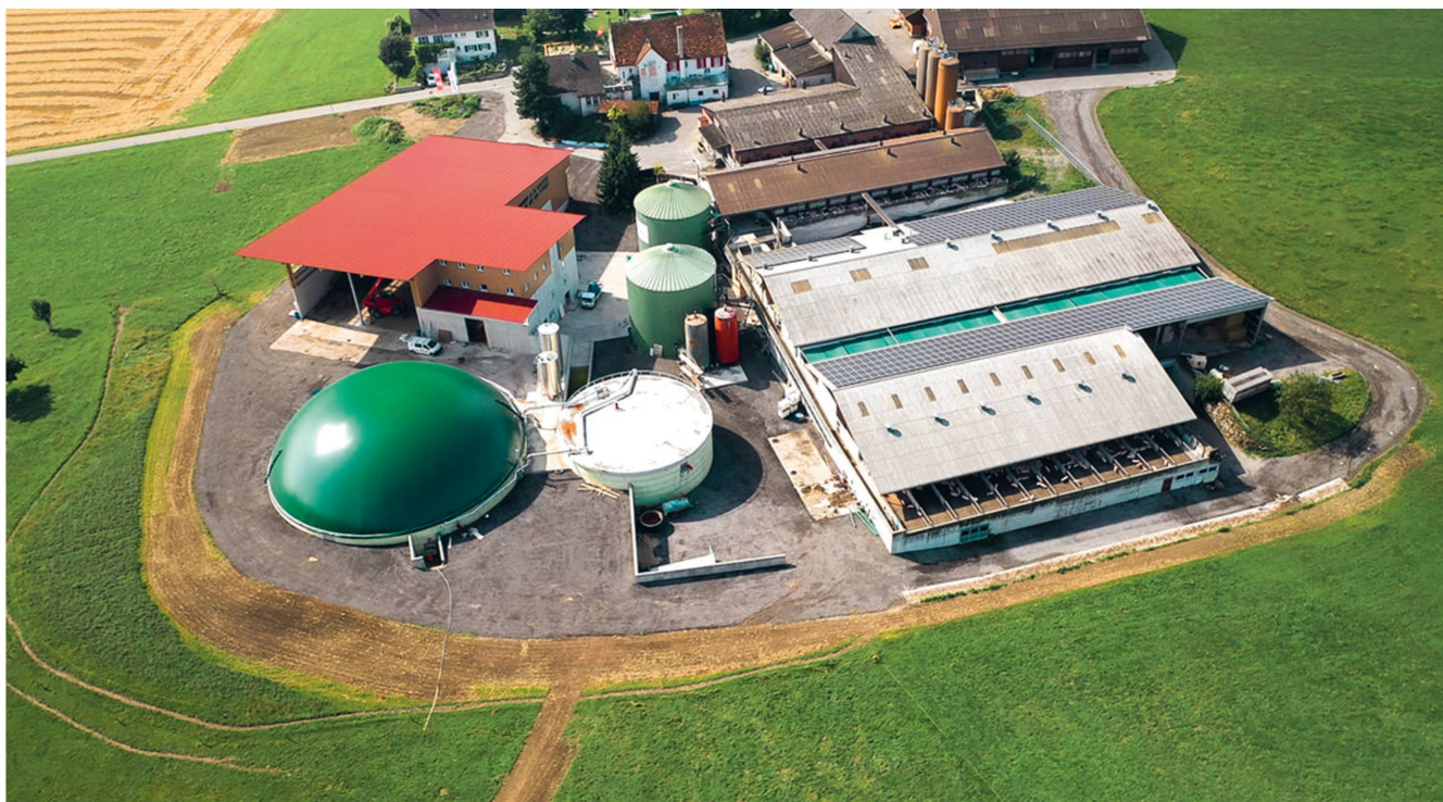
Der Holzhof von Otto Wartmann umfasst eine Käserei, einen Milchwirtschaftsbetrieb und eine Schweinezucht. In der Mitte des Bildes sind die drei Fermenter zur Erzeugung von Biogas zu sehen. Auf den Stallanlagen rechts befindet sich eine der zwei Photovoltaik-Anlagen. Die im Projekt eingebundene PV-Anlage wurde auf dem roten Dach (links im Bild) errichtet und ist auf dem Foto noch nicht abgebildet. Bild: Holzhof
