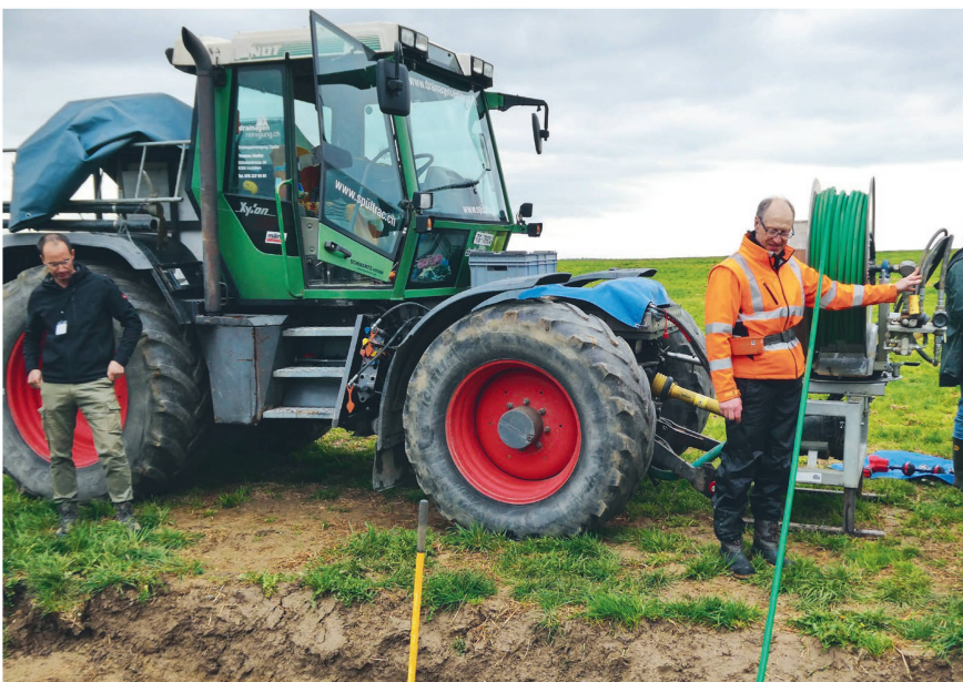
Drainagen brauchen Unterhalt, sie können gespült werden und funktionieren nachher wieder einwandfrei. Bild: Ruedi Hunger
