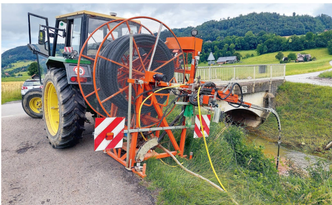
Der «1640» beim Drainagespülen in die Müsche, einem Nebenfluss der Gürbe. Bilder: Rytz
