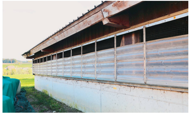
Sowohl Jäger- als auch der Galtssauenstall sind mit einem Schlauchfenster-Lüftungssystem ausgerüstet.
