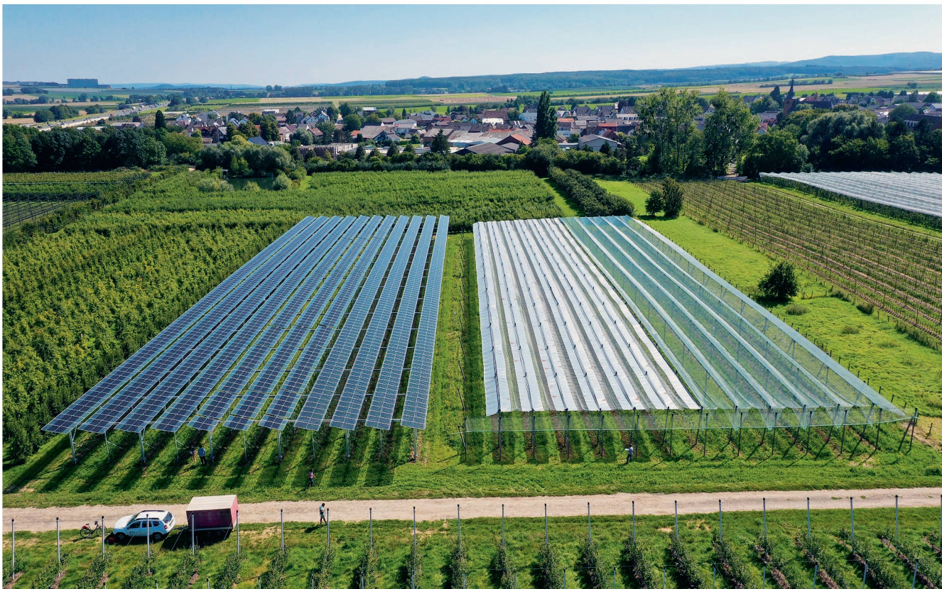
Agri-PV-Anlage bei einer Obstkultur in Geldorf im deutschen Rheinland. Bauern können sich mit der Produktion von Solarstrom eine neue Einnahmequelle erschliessen. Solarmodule haben für die Pflanzen eine Schutzwirkung, vermindern aber auch die Erträge. Bild: Fraunhofer ISE
