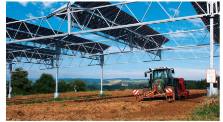
Agri-PV-Pilotanlage des Fraunhofer ISE in Heggenbach im Allgäu. Die Solarmodule sind so hoch angebracht, dass der Traktor für die Aussaat unten durchfahren kann.
