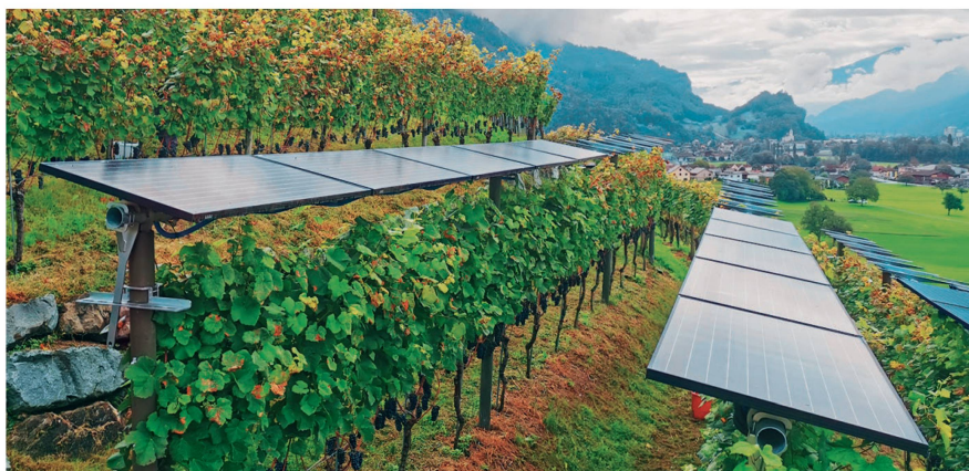
Agri-PV wird in der Schweiz erst in Ansätzen praktiziert: Bild einer privat initiierten Anlage über einem Rebberg in Walenstadt. Die Pflanzen unter den Solarmodulen sind weniger stark von Blattkrankheiten befallen. Da die PV-Module genügend hoch über den Pflanzen angebracht sind, hat die Stromproduktion in diesem Fall keine Ertragseinbussen zur Folge.
