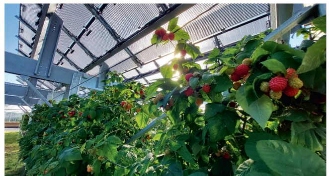
Ende Juli 2021 wurde am Agroscope-Versuchsstandort Conthey VS eine Pilotanlage zur Erforschung der Agri-PV in Betrieb genommen. Die Solarmodule stammen vom Westschweizer Jungunternehmen Insolight und wurden speziell für landwirtschaftliche Anwendungen konzipiert: Die Module sind teilweise durchsichtig, der Lichteinfall kann zwischen 30 und 80% geregelt werden. Damit lassen sich die darunter wachsenden Pflanzen mehr oder weniger stark beschatten.
