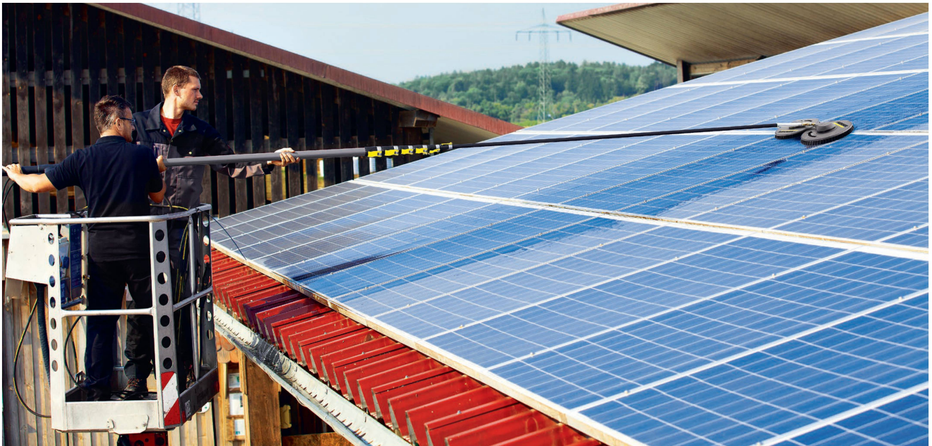
Module können nur dann die maximale Leistung bringen, wenn sie nicht beschattet und verschmutzt sind. Bild: zvg
