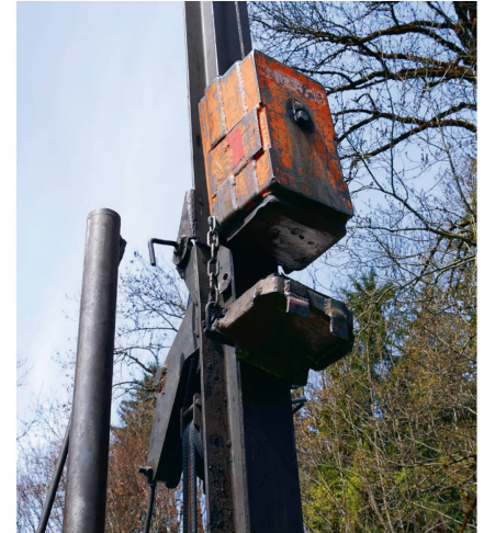
Der Ramm-Klotz wiegt 250 kg und erreicht pro Fallmeter ein Gewicht von einer Tonne.
