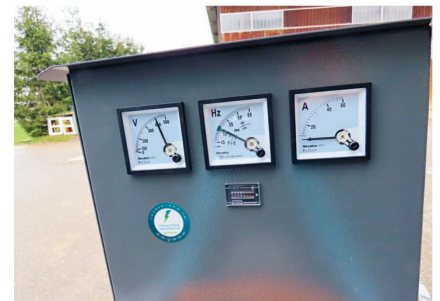
Die analogen Anzeigen beim Generator informieren über Betriebszustände und -stunden.
