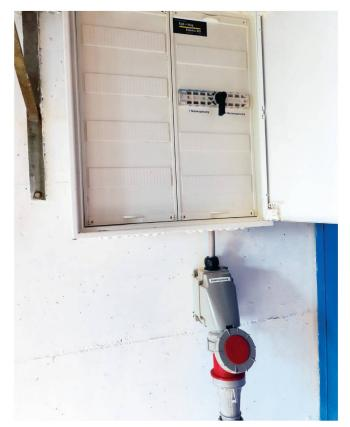
Für die Netztrennschaltung benötigt es eine von einem Fachmann ausgeführte Installation mit Trennschalter (oben) und passender Steckdose für den Generator-Anschluss (unten).
