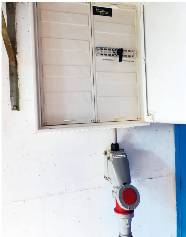
Für die Netztrennschaltung benötigt es eine von einem Fachmann ausgeführte Installation mit Trennschalter (oben) und passender Steckdose für den Generator-Anschluss (unten).
