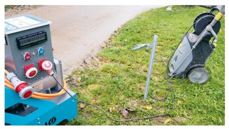
Im Feldbetrieb wird der Erdungsspiess so tief wie möglich in den feuchten Boden gerammt und mit dem Erdungskabel fest verbunden.
