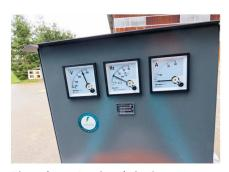
Die analogen Anzeigen beim Generator informieren über Betriebszustände und -stunden.
