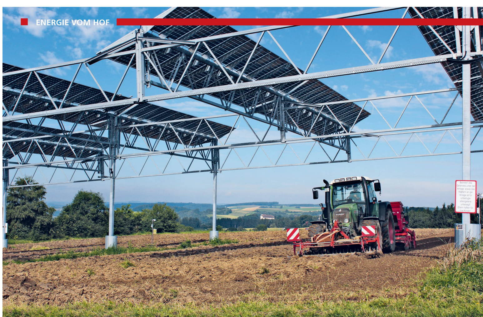
Doppelte Ernte: Oben Solarstrom, unten Ackerkulturen. Dank grossem Boden- und Zwischenreihenabstand ist die Bewirtschaftung mit Maschinen möglich und die Verschattung ist nur leicht. Bild: Tommsdorff
