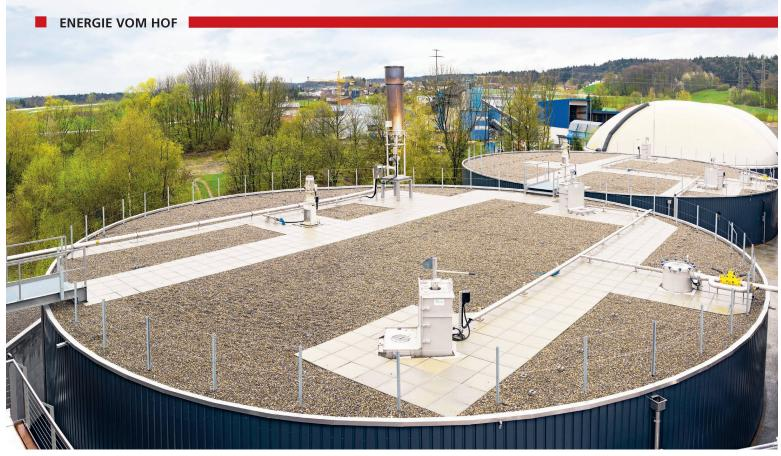
In Nesselnbach AG steht die grösste industrielle Biogasanlage der Schweiz. Im Jahr 2021 produzierte sie aus Speiseresten jeweils 18 Mio. kWh Strom und Wärme. Darüber hinaus wurden 30 Mio. kWh Biogas ins Erdgasnetz eingespeist. Bild: Recycling Energie AG
