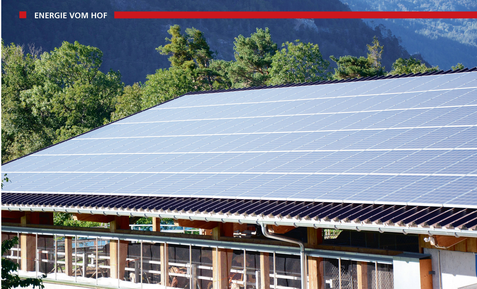
PV-Anlagen nutzen nur einen Teil der Sonnenenergie für die Stromproduktion, daher besteht die Möglichkeit, die Wärme für die Heubelüftung zu nutzen. Bild: R. Hunger
