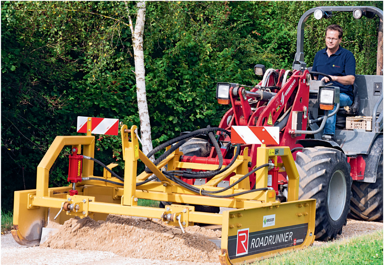
Einfach, aber dennoch effizient: Unterhalt von Naturstrassen mit dem «Roadrunner». Bilder: R. Engeler
