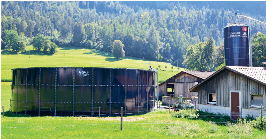
Emissionen entstehen sowohl durch Luftverwirbelungen an der Behälter-Oberkante als auch durch die Lufterneuerung über dem Silo.
