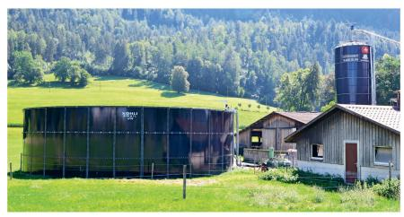
Emissionen entstehen sowohl durch Luftverwirbelungen an der Behälter-Oberkante als auch durch die Lufterneuerung über dem Silo.
