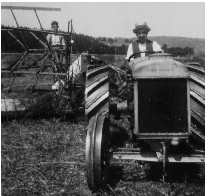
Ein «Fordson F» mit einem Mähbinder von McCormick (um 1925).
