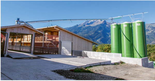
Ein Stocker-Transportleitungssystem mit Turbozyklon. Dank Schalldämpfer ist das Saugsystem äusserst leise.
