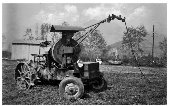
Vor 80 Jahren, 1941, warteten die Ateliers de Constructions Mécaniques de Vevey (ACMV) mit dem vermutlich ersten Elektro-Traktor der Welt auf. Hier die Ausführung mit dem Allis-Chalmers-Chassis, mit dem Stromabnehmer (Trolley) rechts vom Traktor und der drehbaren Kabelrolle mit Gestänge und Kabel auf dem Traktor, darunter der Kasten des Kabelrollenmotors sowie links unter der Kabelrolle die beiden Antriebe. Archivbilder: Franz Morgenegg
