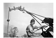
Das Gestänge mit den vier Laufrollen (und kleinen Gegenrollen) und dem Kontaktschalter. Die Rolle wird immer in die jeweilige Arbeitsrichtung gedreht.
