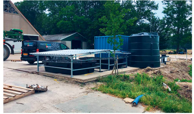
Biologische Systeme basieren auf Verdunstung des Wassers und Abbau der PSM-Rückstände durch Mikroorganismen. Bild: Biopac
