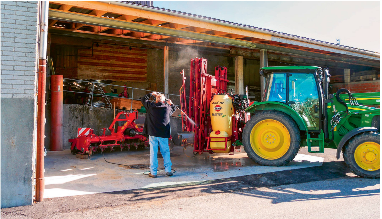
Beispiel mit Güllegrube: Renovation des Bodens, Verlängerung des Daches und Optimierung der Wasserversorgung. Bild: Rütli, Zollikofen
