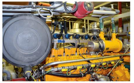
Ein 150 kW-BHKW-Aggregat mit einem Gas-Motor von Liebherr.
