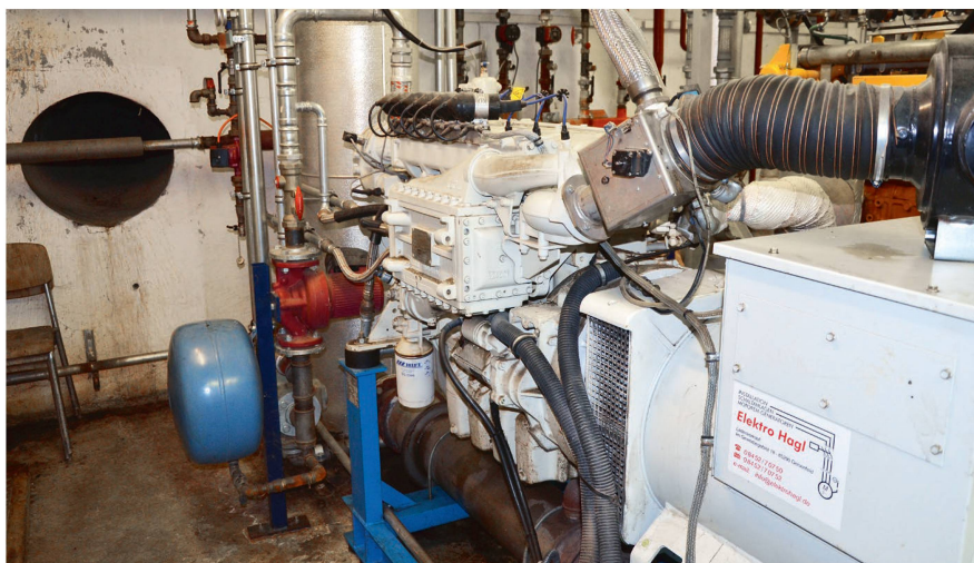
Das nach einer Erweiterung abgelöste BHKW kann weiterhin als Zusatz- oder Reserve-Aggregat genutzt werden.
