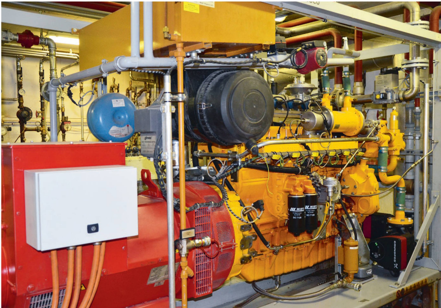
Das BHKW wird oft als Herzstück einer Biogas-Anlage bezeichnet.
