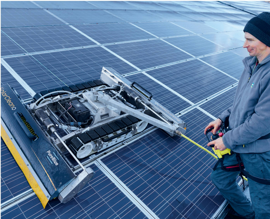
Anton Kaufmann lässt den «SolarCleano» über die Solarmodule huschen. Bilder: D. Senn
