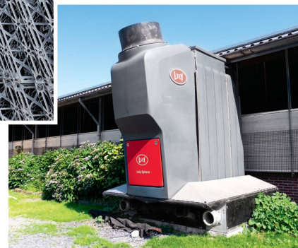
Durch den ausserhalb des Stalls positionierten «N-Capture» fliesst die mit Ammoniak angereicherte Luft. Im Filter entsteht je nach Säurezugabe Ammoniumnitrat oder Ammoniumsulfat.
