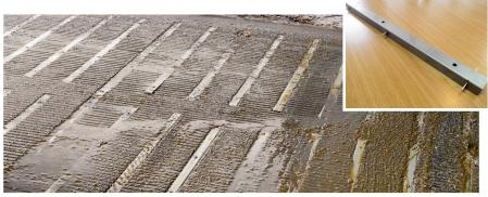
Die Spaltenböden werden mit solchen Paneelen ausgekleidet. Der Kot bleibt oben, durch die Öffnungen gelangt der Harn in ein unterirdisches Lager.
