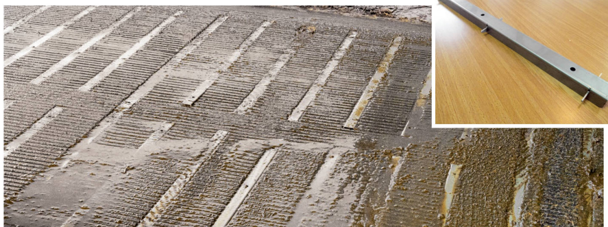
Die Spaltenböden werden mit solchen Paneelen ausgekleidet. Der Kot bleibt oben, durch die Öffnungen gelangt der Harn in ein unterirdisches Lager.
