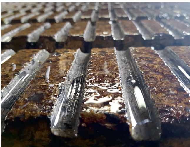
Der Nutenfräsmotor für Spaltenböden setzt sich aus 60 Diamantscheiben zusammen, die Nuten von 4 bis 5 mm Tiefe und 12 mm Breite herausfräsen. Bilder: Jossi Farm Equipment
