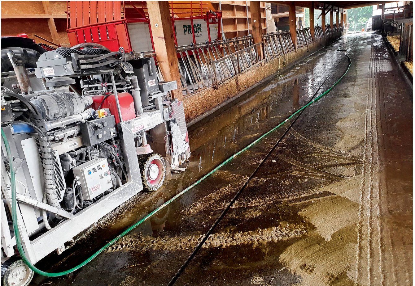
Die Leistungsfähigkeit bei der Nuten- und Rillenfrästechnik variiert zwischen 500 und 550 m 2 /Tag je nach den Verhältnissen vor Ort und der Unterstützung durch den Kunden. Bild: Jossi Farm Equipment
