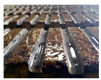
Der Nutenfräsrotor für Spaltenböden setzt sich aus 60 Diamantscheiben zusammen, die Nuten von 4 bis 5 mm Tiefe und 12 mm Breite herausfräsen. Bilder: Jossi Farm Equipement
