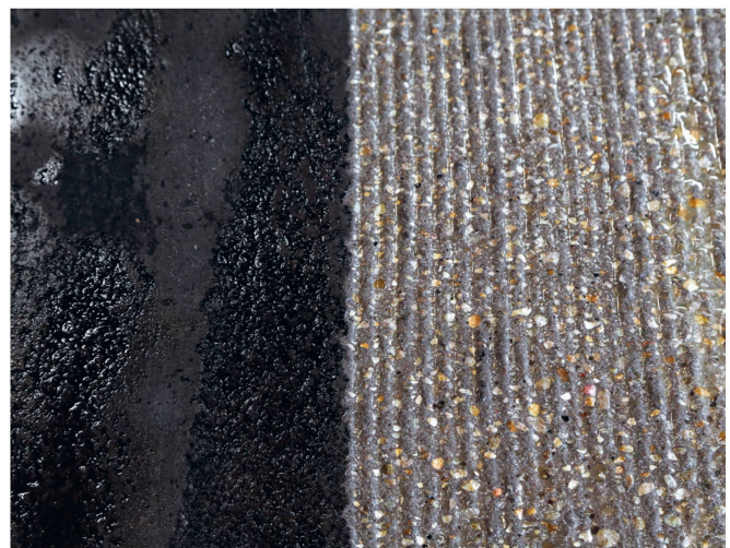
Nur für Festbeton vorgesehen: Die Rillenfrästechnik formt kleine Rillen von 3 bis 4 mm Tiefe (rechts). Frischbeton kann man erst nach einer Zeitspanne von 6 Monaten behandeln.
