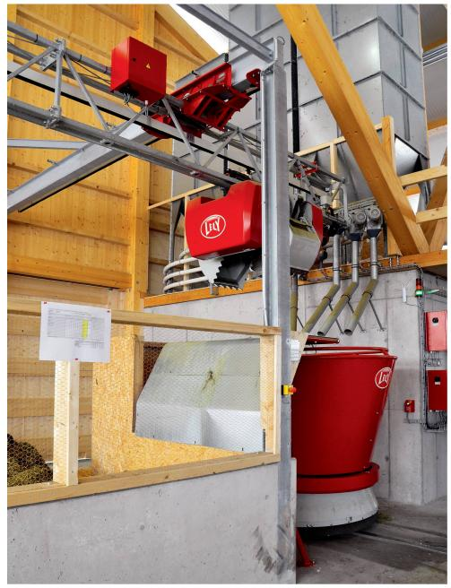
Die Erleichterung durch AFS liegt in der Automatisierung der Befüllung, des Mischens und der Futtervorlage. Bild: R. Hunger
