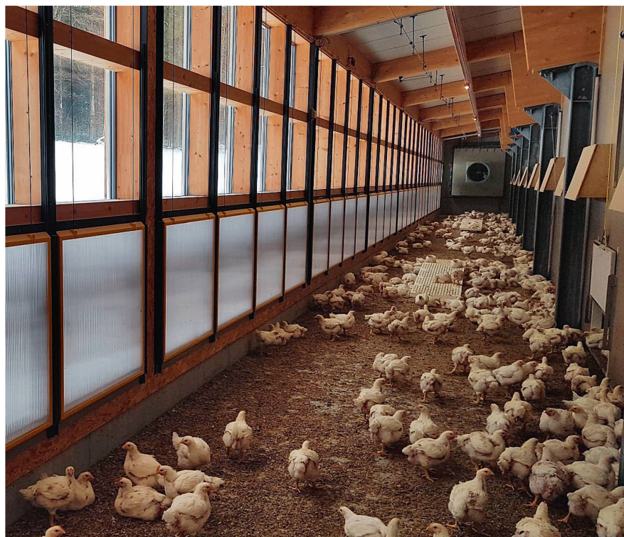
Pouletstall in Zimmerwald: Bei kalten Temperaturen sind die Schieber des Wintergartens geschlossen. Ganz hinten sieht man den Zuluftwärmetauscher, womit durch das Verbundsystem immer frische, vortemperierte Luft in den Wintergarten gelangt.
