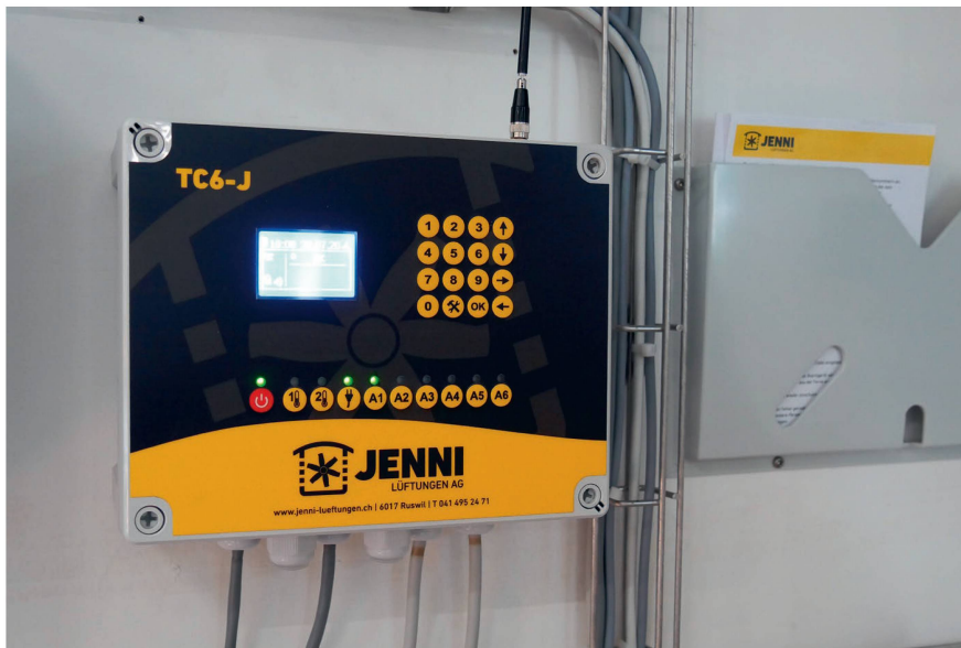
Funktioniert der Alarm der Stallbelüftung noch? Steuerungssysteme, die auf dem 2G-Mobilfunknetz basieren, sollten noch vor der Netzabschaltung von 2G durch ein neues Gerät ersetzt werden. Bilder: H. Röthlisberger
