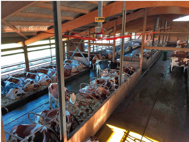
Mit den «Zefiro»-Grossraum-Deckenventilatoren werden grosse Flächen im Hallenstall energiesparend und leise belüftet. Bilder: zvg
