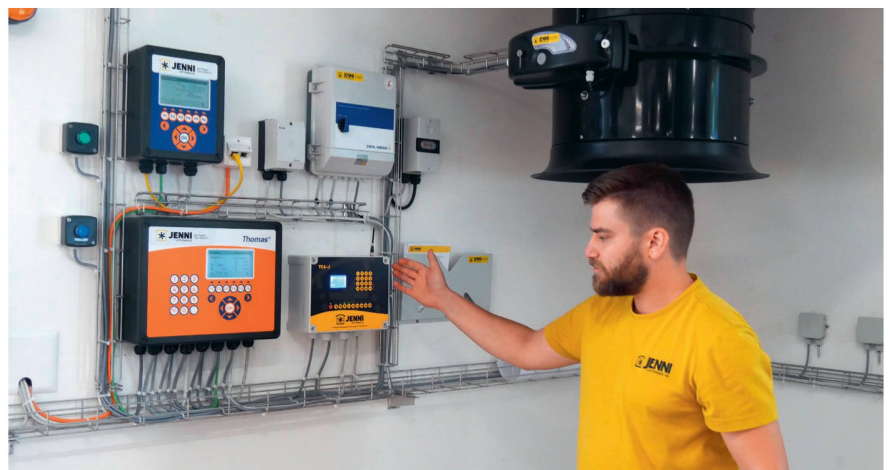
Alarmierung, Drehzahlregelung, Energiesparmodus und vieles mehr: Die automatisierte Steuerung von Lüftungsanlagen bietet ein grosses Potential, sagt Thomas Jenni.
