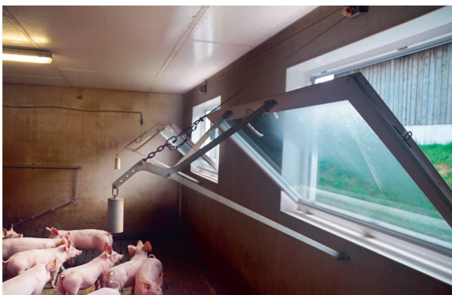
Gewichte am Seilzug ziehen die Kippfenster nach unten.
