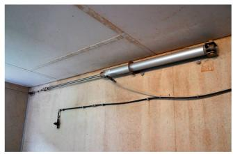
Der Druckzylinder schliesst via Seilzug die Fenster.
