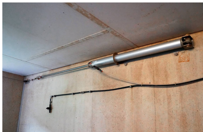
Der Druckzylinder schliesst via Seilzug die Fenster.
