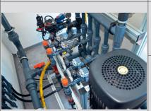
Links: Dosier-Station für Dünger und Säure. Damit im Fall von Heidelbeeren der pH-Gehalt im Topf gleichbleibend ist.
