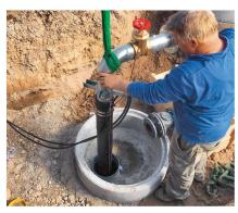
Im 13 m tiefen Grundwasserschacht baute Rolf Kuhn kürzlich ein neue Unterflurpumpe ein.
