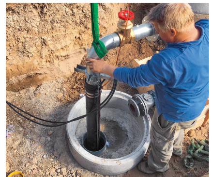
Im 13 m tiefen Grundwasserschacht baute Rolf Kuhn kürzlich eine neue Unterflurpumpe ein.
