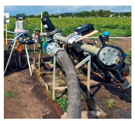
Kopfstation des Netafim-Tropfbewässerungssystems mit Düngerdosierer, Filter, Druckminderer und Automatisierungseinheiten.
