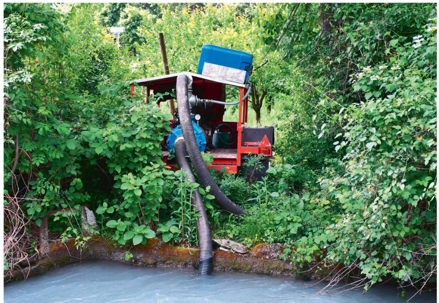
Wo die Wasserableitung nicht über natürliches Gefälle möglich ist, kommen Pumpen zum Einsatz. Bild: R. Hunger
