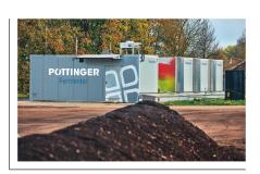
Containerbox. Durch den modularen Aufbau lässt sich die Anlage an individuelle Anforderungen mit Jahreskapazitäten von 1000 bis 6000 Tonnen anpassen.
