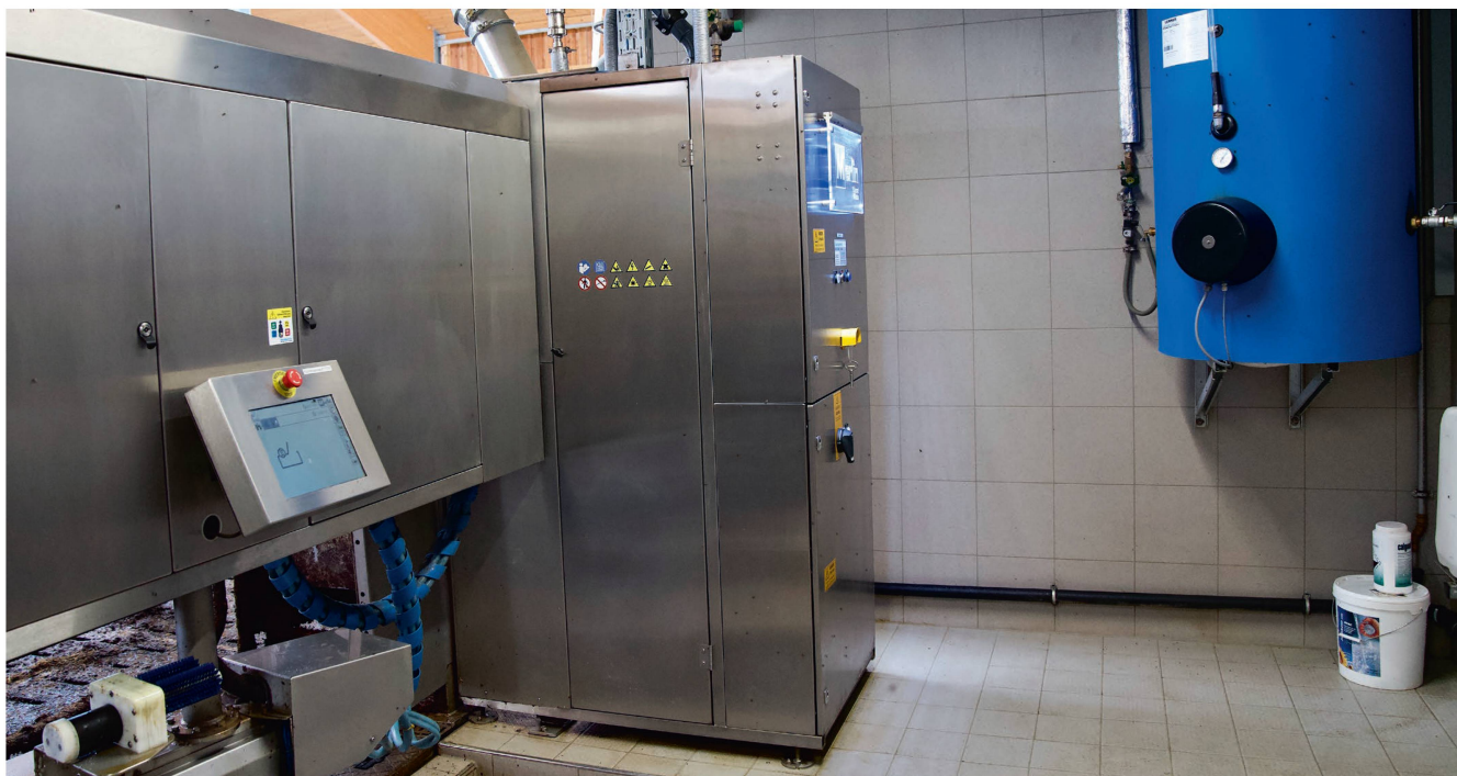
Überschüssige Energie aus Fotovoltaik (oder Windkraft) wird auf dem Hof von Franz X. Demmel aus dem bayrischen Schönrain bei Königsdorf für die Aufbereitung von Kochendwasser für die Melkanlage, hier von Lemmer-Fullwood, verwendet. D. Senn
