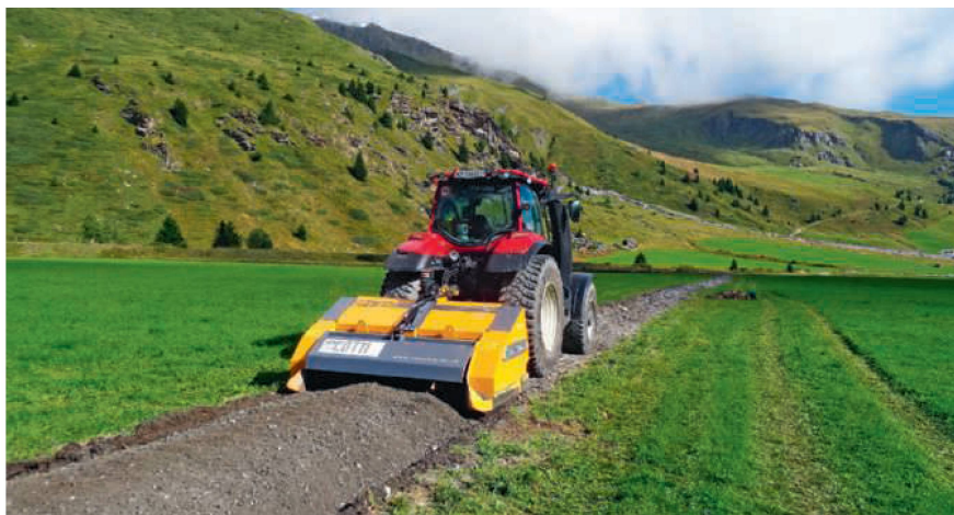
Je nach Zustand sind der Einsatz eines Steingrubbers, gefolgt vom Steinbrecher, und eine Rückverfestigung mittels Rüttelplatte notwendig. Bild: Cotti
