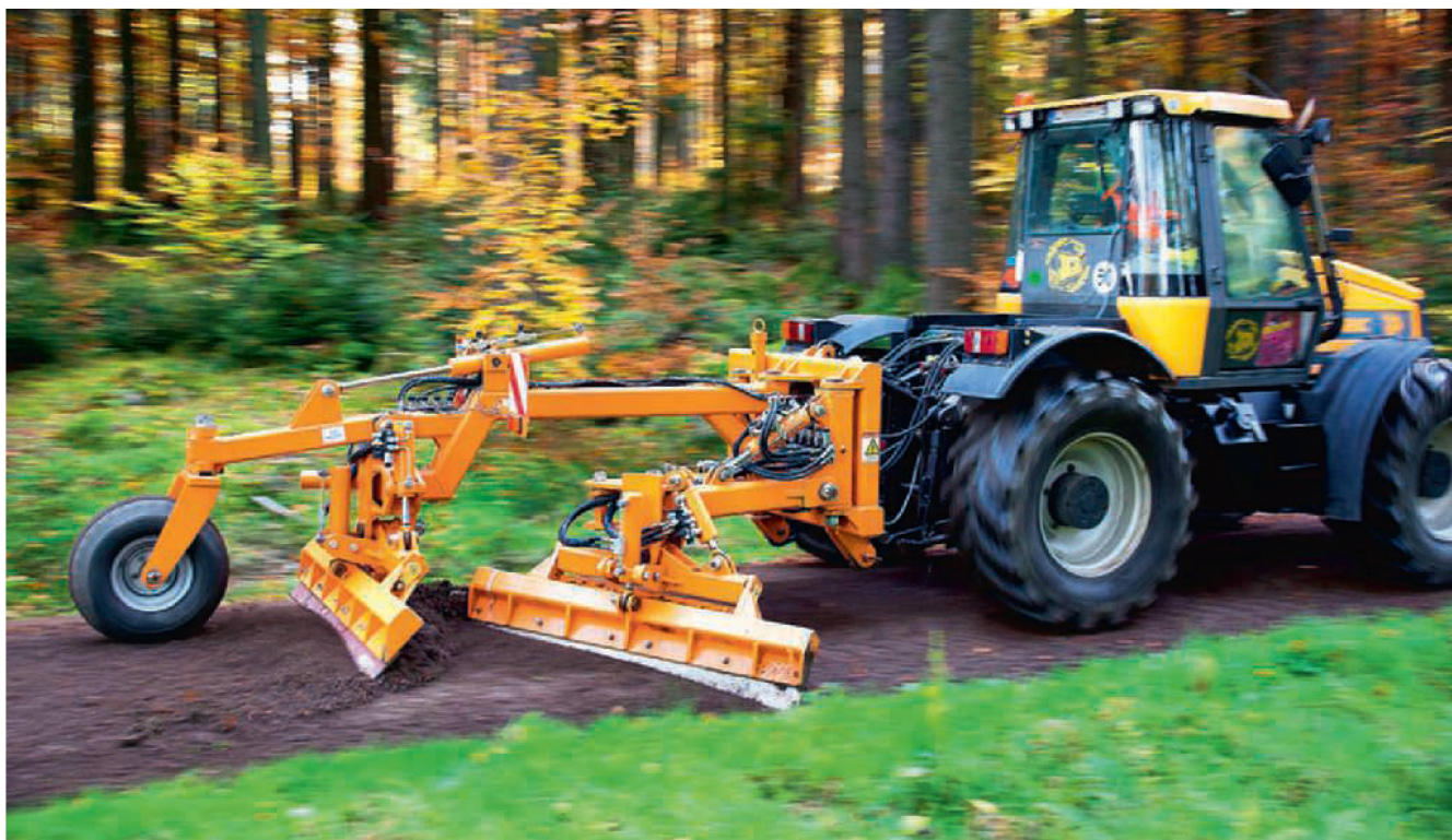
Das «R 2017»-Kombigerät bildet aus dem vorhandenen Wegbaumaterial eine neue Verschleisschicht. Bild: KWF
