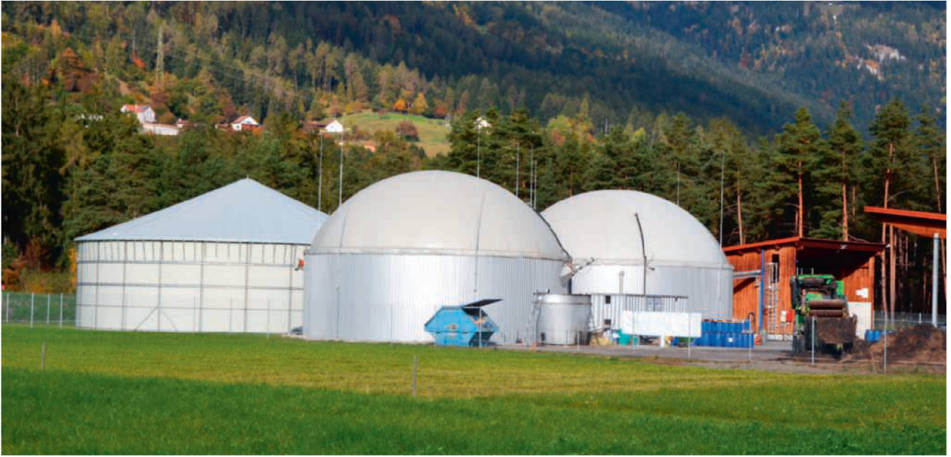
Biogasanlagen-Betreiber müssen eine eventuelle Substratvorbehandlung auf das Ausgangsmaterial abstimmen. Bild: Ruedi Hunger
