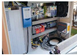
Blick in den Steuerungskasten mit dem Frequenzumrichter (links).
