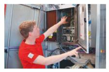
Elektroplatinen werden auf mechanische Beschädigungen und Korrosion kontrolliert.
