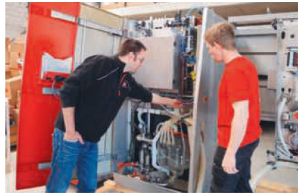
Durch Mäuse angefressene und spröde Kabel werden konsequent ersetzt.
